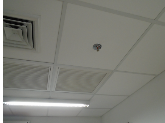
ภาพที่ 3-16 ระบบหัวกระจายน้ำดับเพลิง
